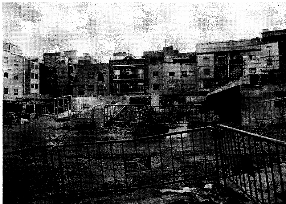
Obres a l'estació de metro de Santa Rosa de la futura línia 9, fa uns dies. / I.M.
