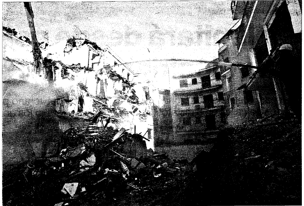
► Obras de derribo para construir la estación de Santa Rosa y una plaza en Santa Coloma, ayer.
