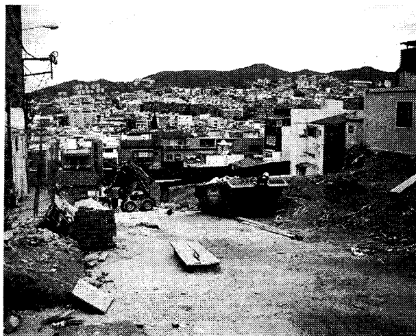
La part alta del passatge de la Victòria, en obres. / I.M.
