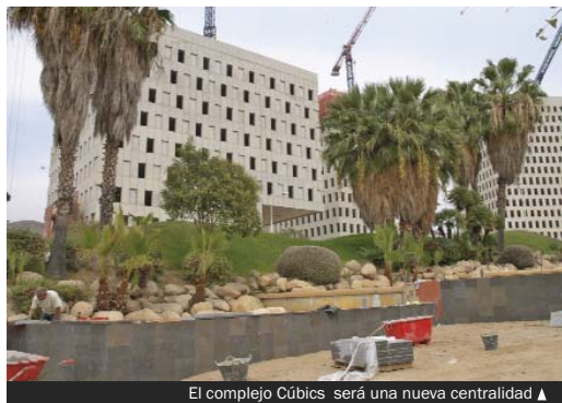
El complejo Cúbics será una nueva centralidad ▲
