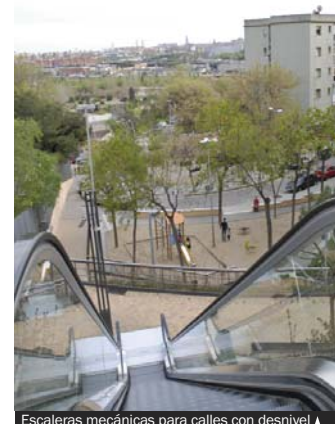
Escaleras mecánicas para calles con desnivel ▲
