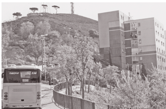
Este proyecto supone la restauración medioambiental y paisajística de la zona.
